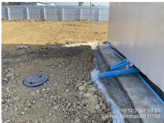
(8) ระบบบำบัดเบื้องต้น (บ่อเกรอะ-บ่อซึม)
